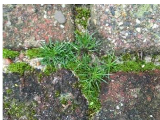
Mos en liggende vetmuur
